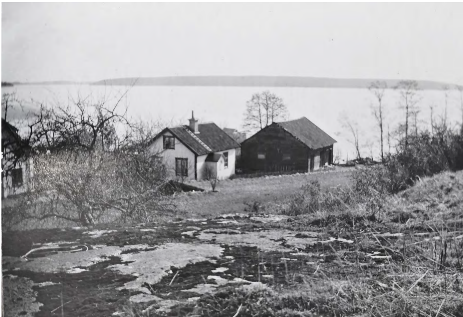
En snarlik bild i förhållande till den föregående, men här ser man också den ekonomibyggnad som i början av 1900-talet låg nere vid vattnet. Kanske var den en rest av garveri- och/eller tegelbruksverksamheten. Fotot ingår i Arvid Drakes fotosamling. Källa: Sigtuna Museum.
