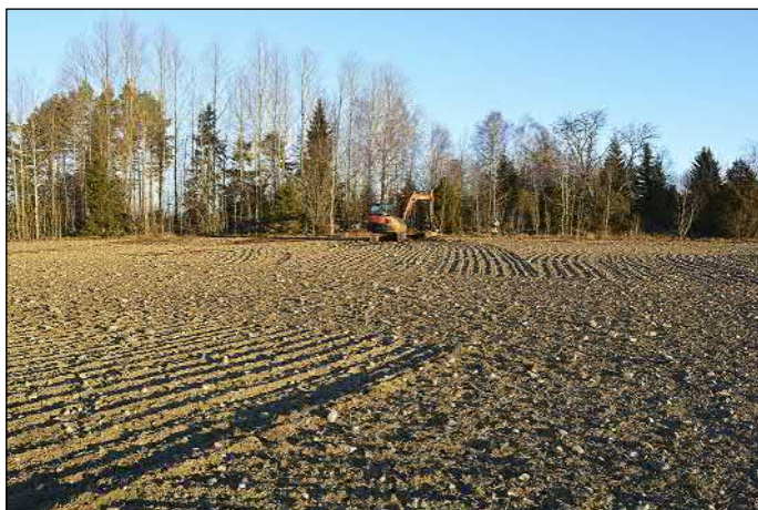
Figur 14. Schaktning inom boplatsläget objekt 5. Foto från söder.
