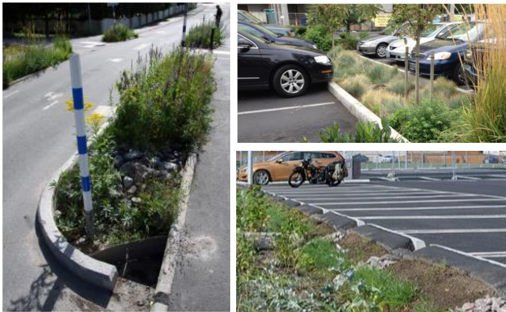
Figur 19. Exempel på nedsänkta växtbäddar i stadsmiljö, med kantsten som tillåter ytlig avrinning till växtbädden.
