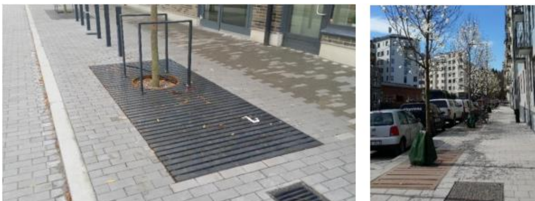
Figur 17. Exempel på skelettjordskonstruktion från ytan, Norra Djurgårdsstaden.
