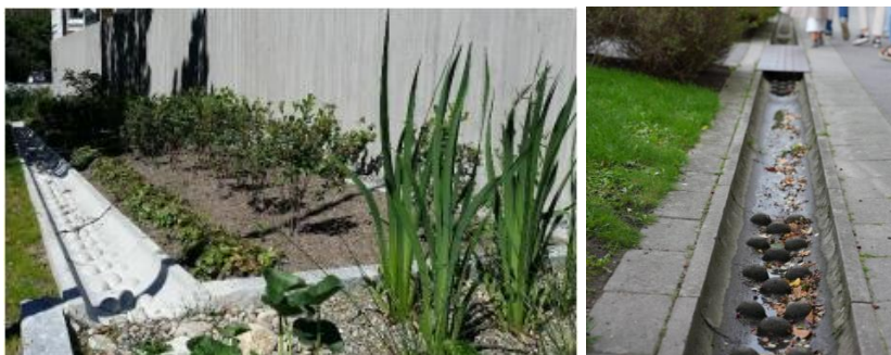
Figur 16. Möjlig avledning från stuprörens utlopp till skelettjordskonstruktion.
