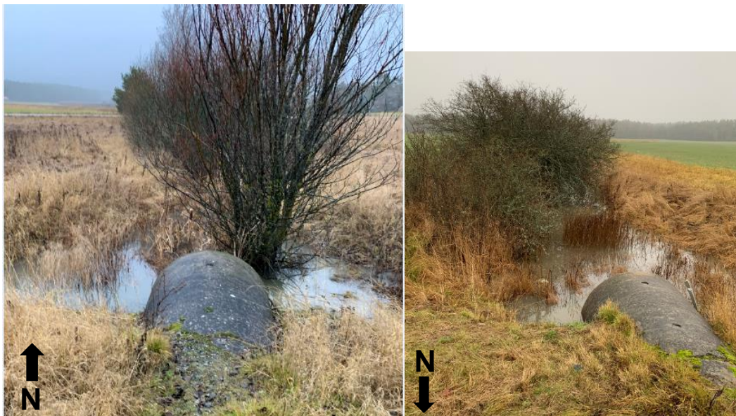
Figur 14. Trumma under väg 263. Bild till vänster visar trummans norra del. Bild till höger visar trummans södra del. Både norr och söder om trumman finns mycket växtlighet i form av vass, träd och buskar. Bilder tagna under platsbesök 2019-11-27.
