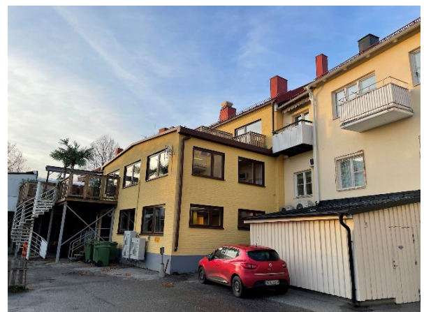
Tillbyggnad intill Koppardosan 2A
