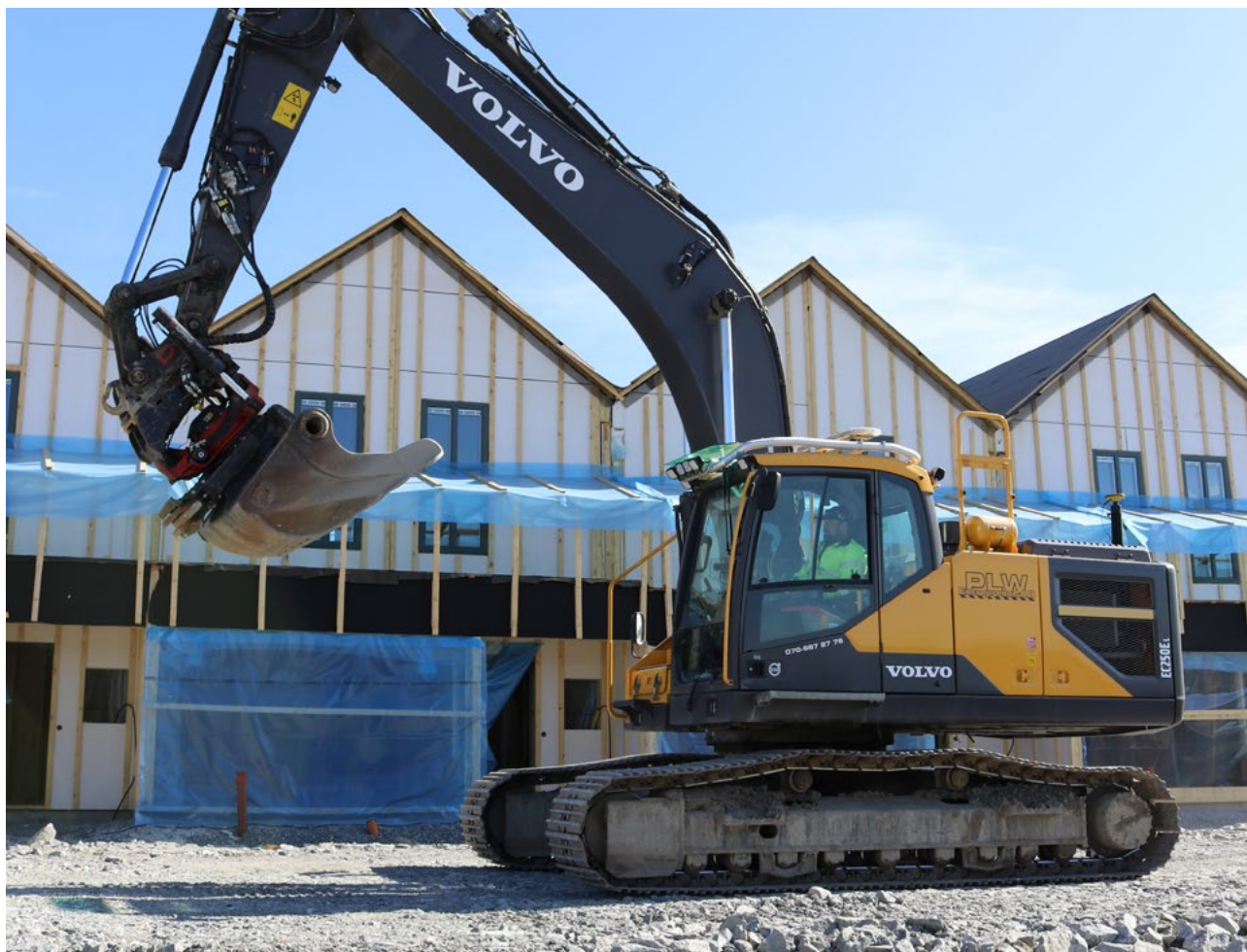
Pågående nybyggnation i Steninge slottsby. Foto: Sigtuna kommun
