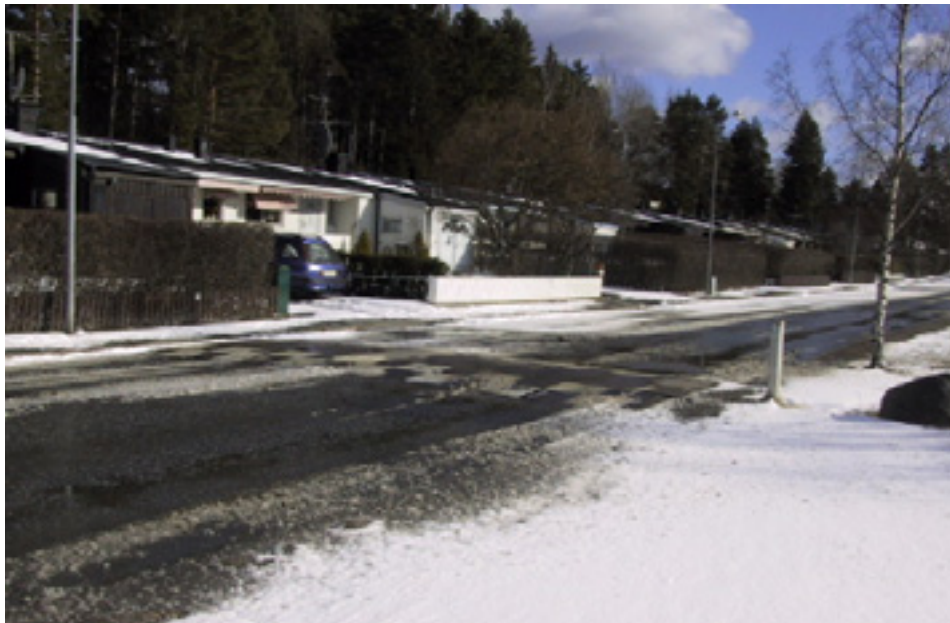
Återkommande gupp på Aspvägen i Sigtuna kommun..
