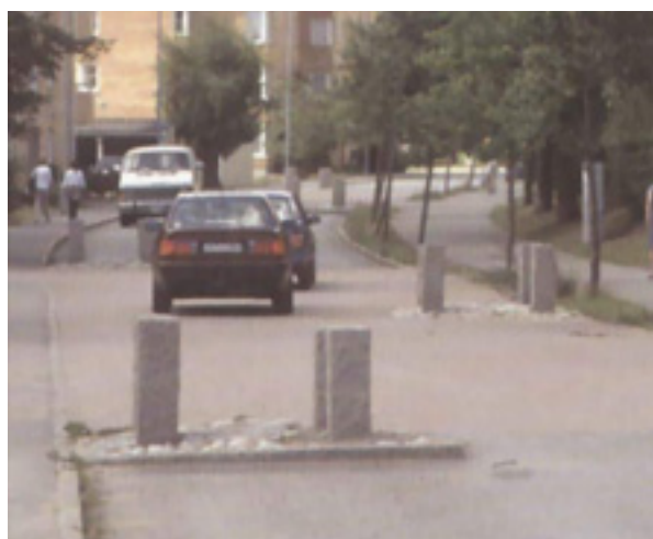
Exempel på sidoförskjutning, Moränvägen i Haninge
