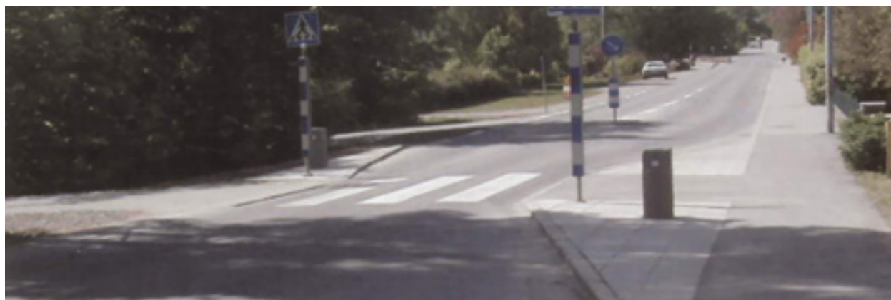
Avsmalning på Västergårdsvägen i Huddinge
