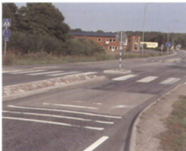
Exempel på väggudde, Teknikvägen i Vallentuna
